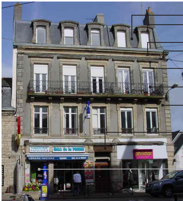
Immeuble fin 19 e s, avec balcon filant au 2 e étage
