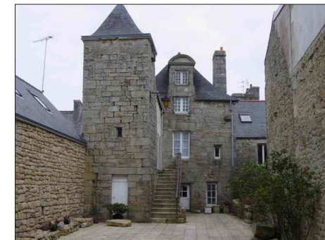
14, rue de Gaulle : façade sur cour d'une maison de plan allongé, avec corps postérieur et latrines dans une tour
