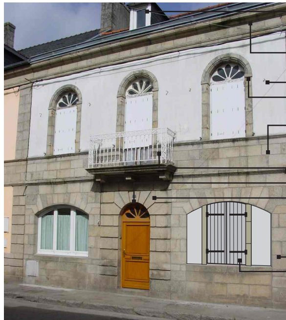
Maison fin 19 e s, façade à modénature soignée, rue de Gaulle
