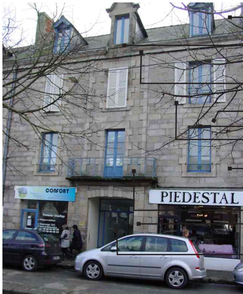
Immeuble vers 1890 à façade en pierre de taille
