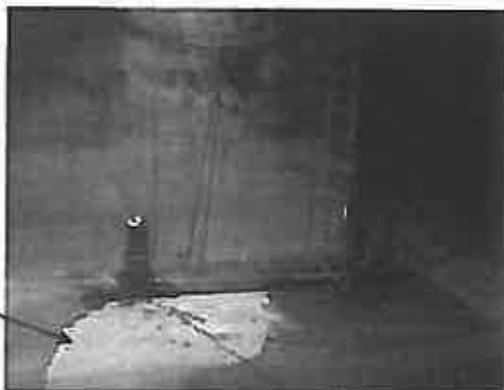
Avec un pH des matières de vidange aux alentours de la neutralité, il n'est peut-être pas nécessaire de reprendre le revêtement, mais un contrôle visuel du béton sera à apporter dans quelques mois.
