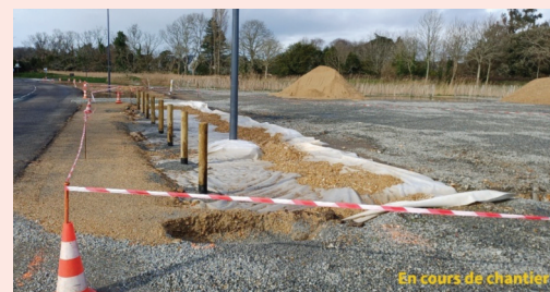
En cours de chantier
